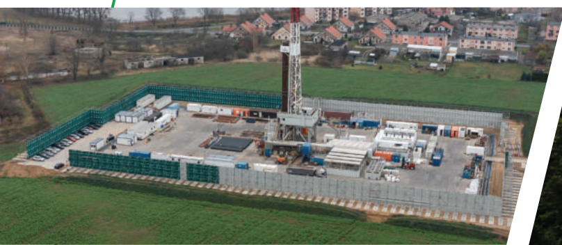
Tymczasowy ekran akustyczny o długości 500 metrów.
