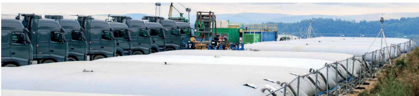
Mobilna baza wody o poj. 3000 m 3 .
